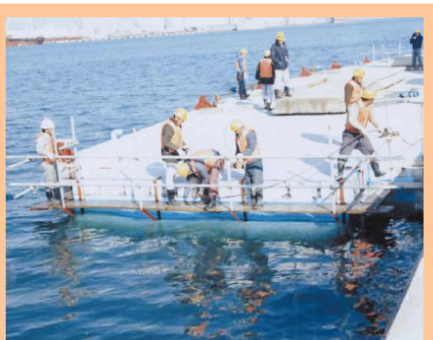
上床版鋼材挿入
