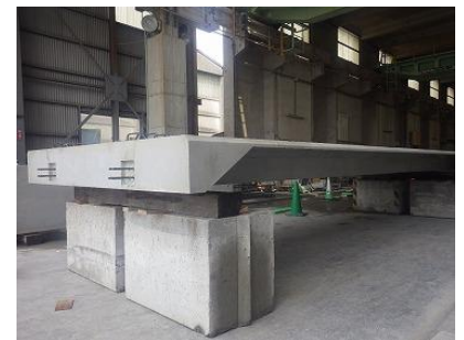
写真-3 床版部材外観
