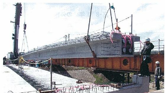
写真-7 架設状況
