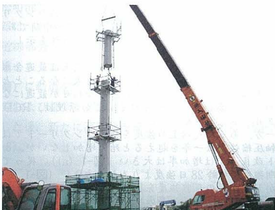
写真-14 プレキャストセグメントの架設
