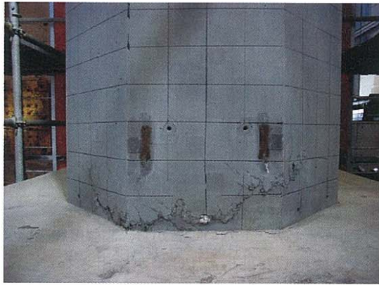
写真-4 破壊状況（基部圧縮縁）
