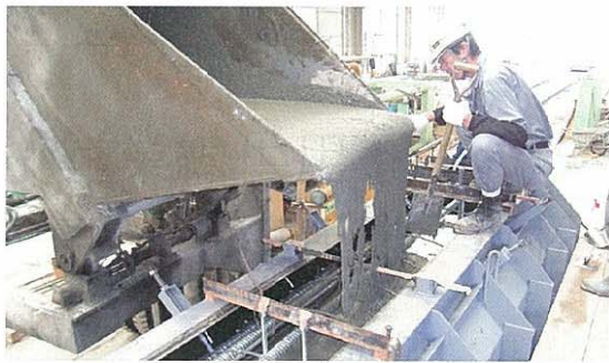
写真-12 打設状況
