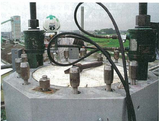
写真-15 緊張状況
