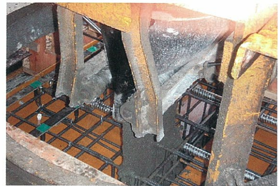
写真-6 主桁打設状況
