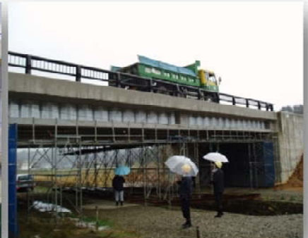
実橋載荷試験
