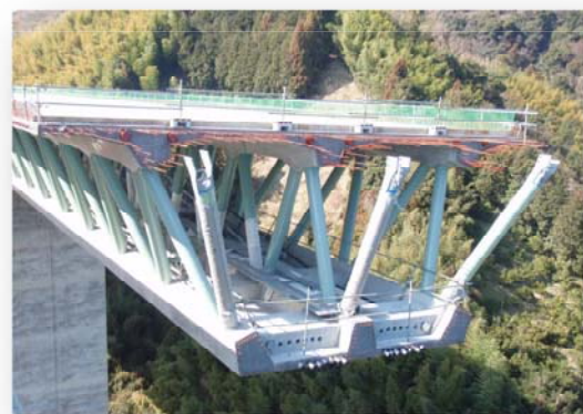
施工段階の主桁断面
