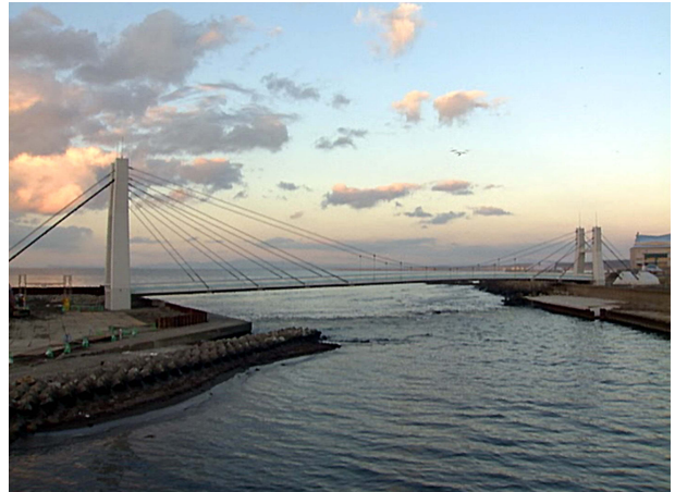
写真-1 なぎさ・ブリッジ全景
