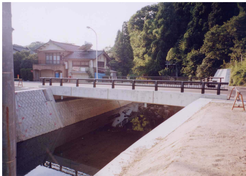
写真5 完成した仮生橋
