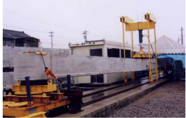
写真2 載荷実験状況
