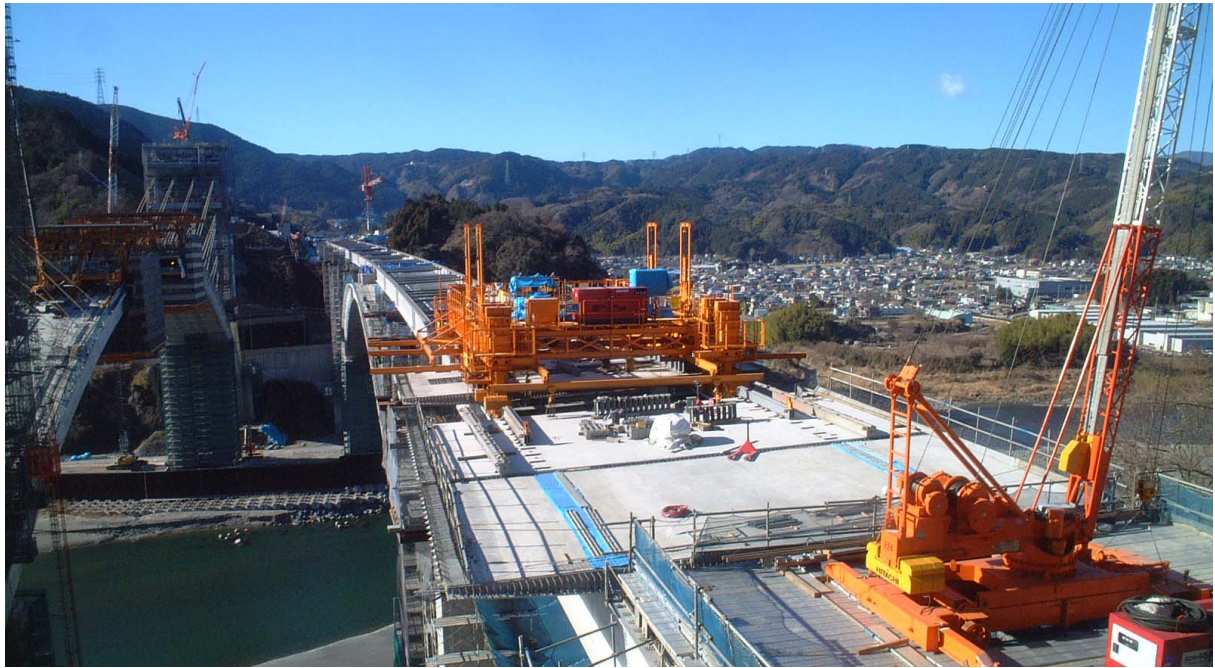
プレキャスト床版架設状況写真
