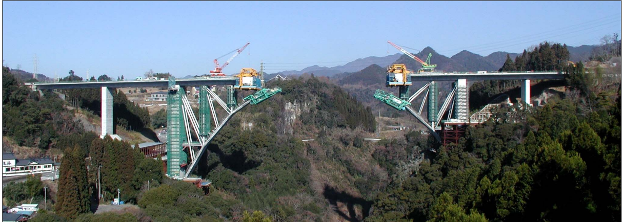
写真 - 1 トラス張出し架設
