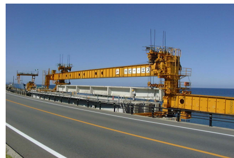
写真 - 3 主桁撤去全景
