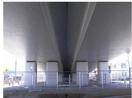
写真-2 工事完了後
