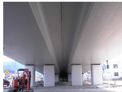
写真-15 工事完了後
