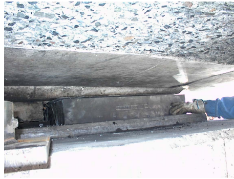
写真 - 10 支承取り替え状況
