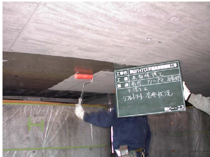
写真-13 下地層塗布状況
