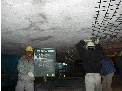
写真-11 補強材取り付け状況
