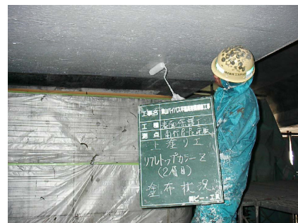
写真-14 上塗り塗布状況
