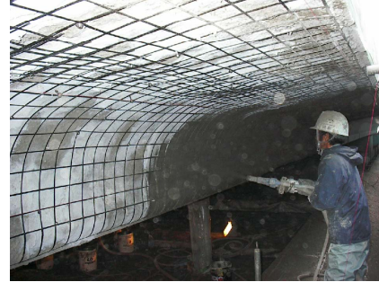
写真-12 仕上げ層吹き付け状況
