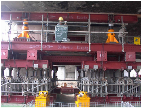
写真 - 9 支保工設置状況
