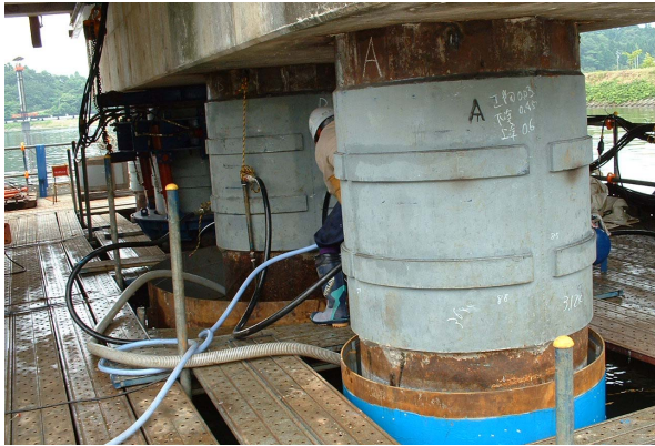
写真 - 2 反力用鋼板
