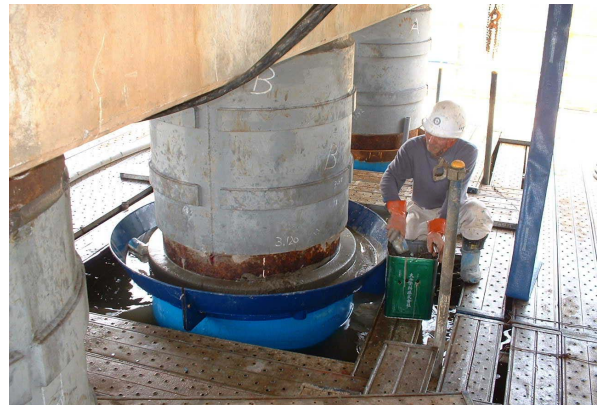
写真 - 5 モルタル充填
