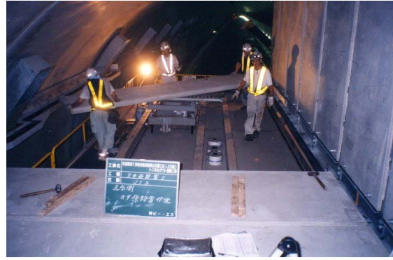
写真 - 2 天井板設置状況
