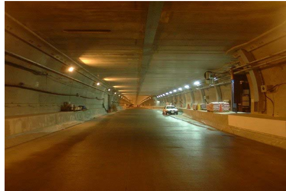
写真 - 4 天井板設置完了
