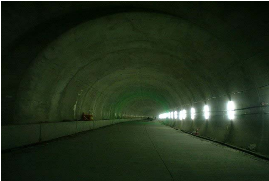
写真 - 3 天井板設置前
