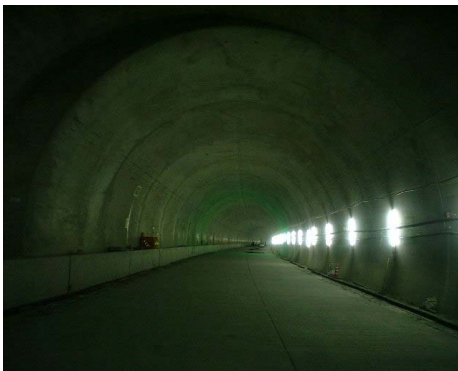
写真 - 8 天井板設置前
