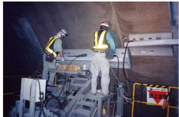
写真-2 受け台設置状況
