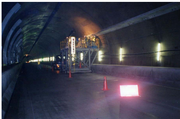
写真-1 受け台設置専用台車
