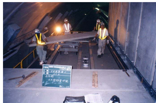
写真 - 6 天井板設置状況
