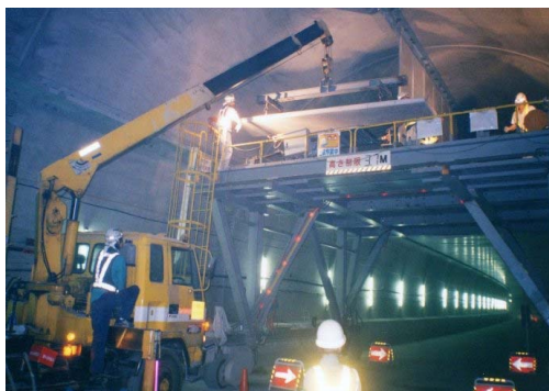
写真 - 5 天井板荷揚げ状況
