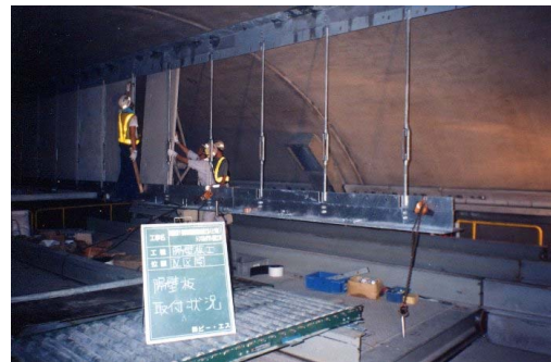
写真 - 4 隔壁板設置状況
