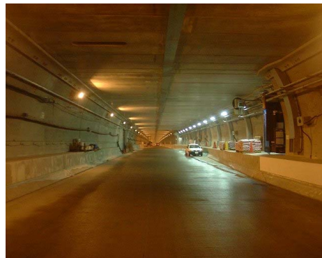
写真 - 9 天井板設置完了
