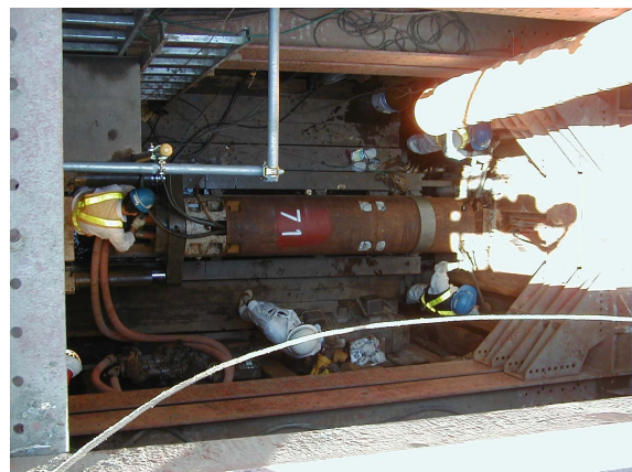
写真 - 7 曲線誘導機推進状況
