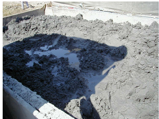
写真 - 8 掘削残土
