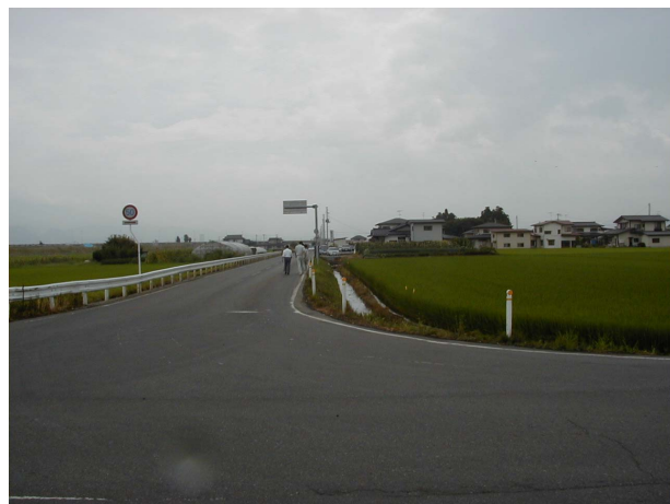
写真-1 現場全景
