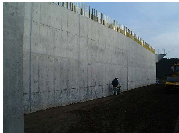
写真 - 1 A1橋台背面
