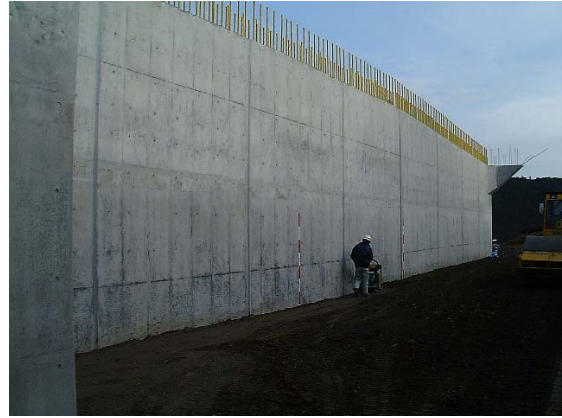
写真 - 3 A 1 橋台背面
