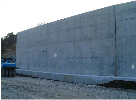
写真 - 2 A 1 橋台前面
