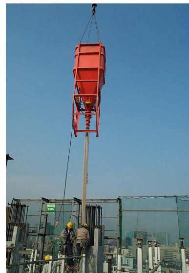
写真 - 1 柱コンクリート打設状況
