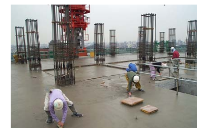
写真 - 2 梁スラブコンクリート打設状況
