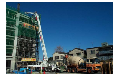
写真 - 1 柱コンクリート打設状況
