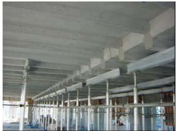
写真 - 7 5階スラブ見上げ
