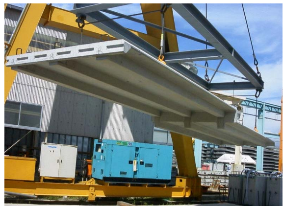
写真-2 段差付きプレキャストスラブ
