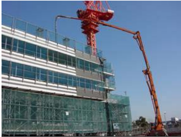
写真 - 4 5階後打ちコンクリート打設状況
