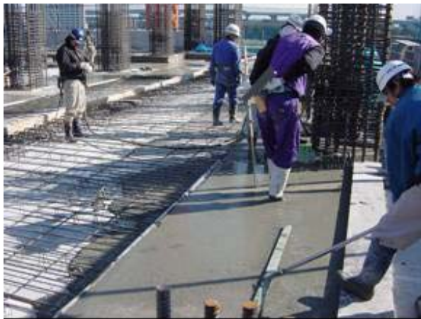
写真 - 5 5階後打ちコンクリート打設状況
