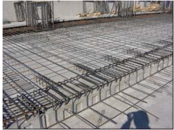
写真 - 6 5階スラブ配筋状況
