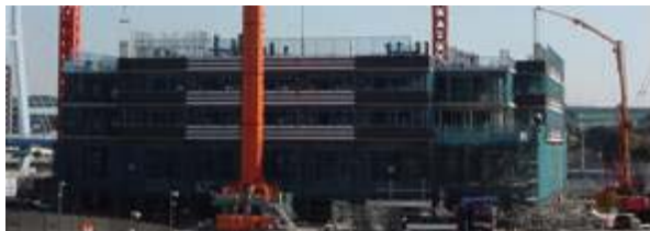
写真-1 施工状況(A棟)
