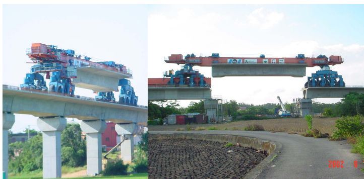
写真 - 1 プレテン箱桁架設状況 (700tf 約550桁)
