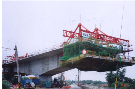
写真 - 13 VSL 張出し架設状況
