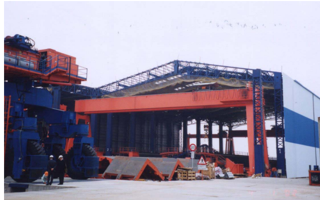
写真 - 1 箱桁製作ヤード
