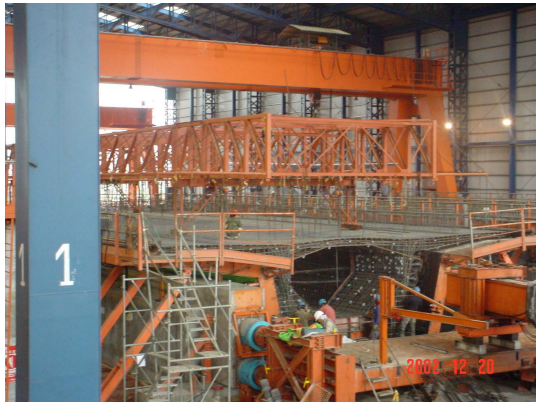
写真 - 6 P S M桁製作状況
