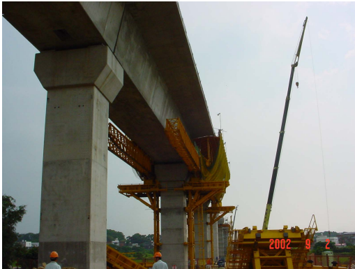
写真 - 10 移動支保工施工状況
