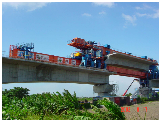
写真 - 8 P S M桁架設状況
