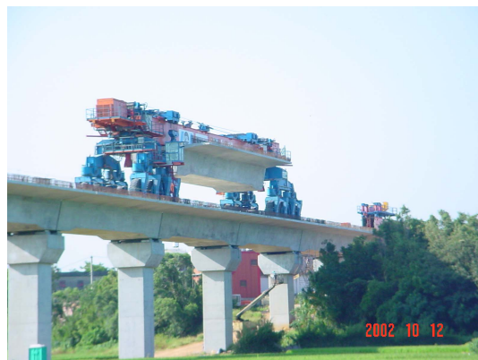
写真 - 7 P S M桁運搬状況
