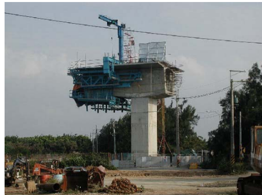
写真 - 14 Freyssinet の張出し架設状況
