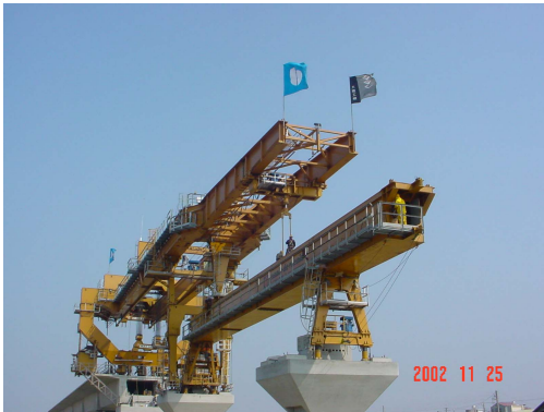
写真 - 12 C-270 工区 PSM 架設設備
