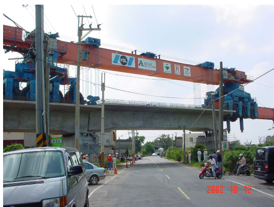
写真 - 9 P S M桁架設状況
