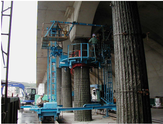
写真 - 1 ワイヤーラッピング工法用施工機械
