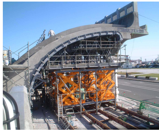
写真 - 2 ドーム補修用移動型枠
