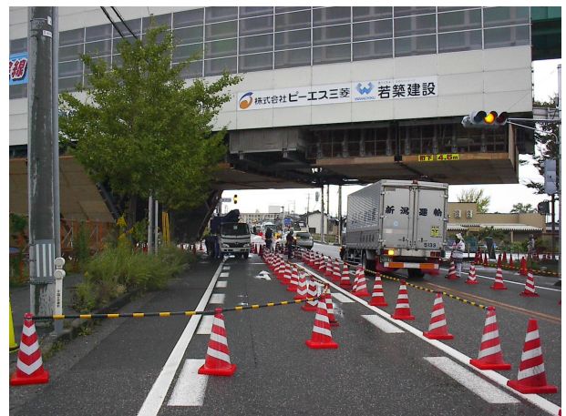
写真-2 国道交差点での支保工移動状況
