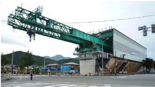
写真-1 移動支保工(移動時)
