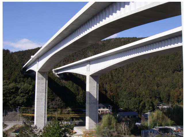
写真-3 完成写真
