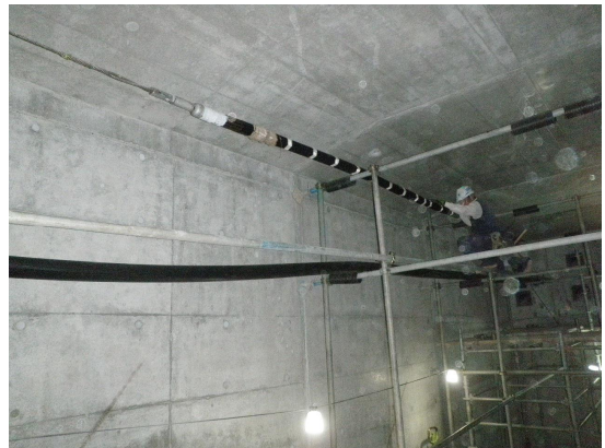
写真-3 外ケーブル挿入状況
