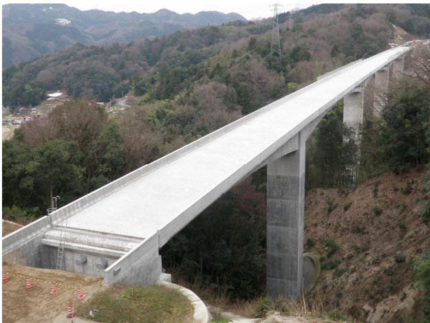
写真-1 工事完了後全景
