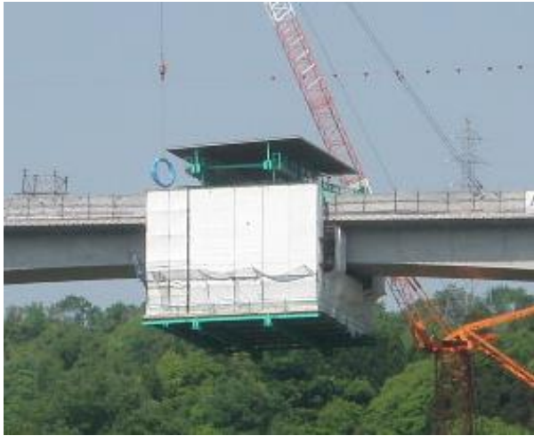
写真-2 移動作業車による中央併合状況
