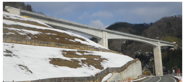
写真-4 完成写真
