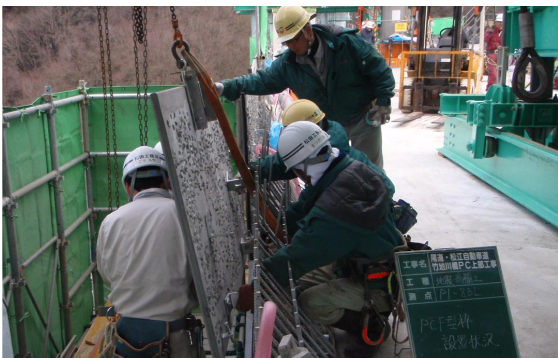
写真-3 PCF 型枠据付状況
