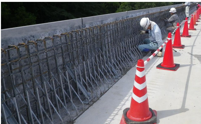
写真-2 PCF型枠を用いた壁高欄の施工状況 (鉄筋組立)
