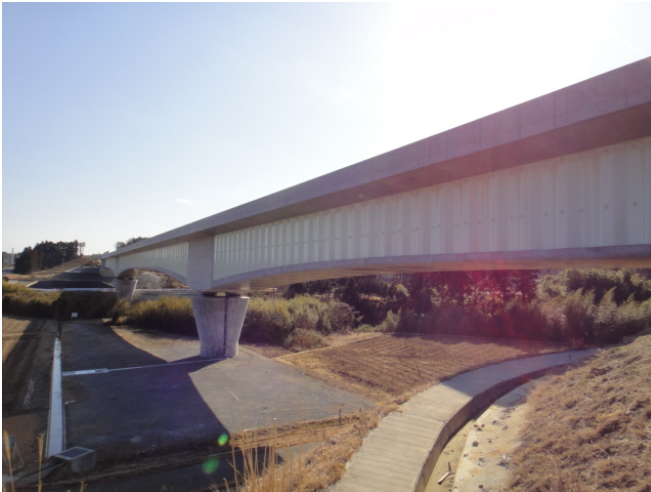
写真-1 工事完了後全景
