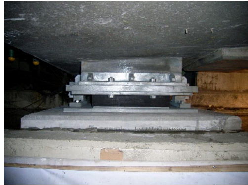
写真-4 支承設置状況（交換後）
