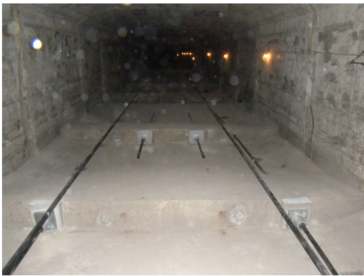
写真-2 外ケーブル配置状況
