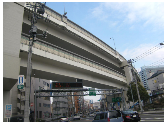
写真-5 工事完了後写真（三・27～三・26 区間）
