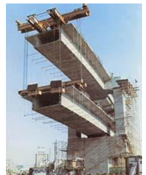
写真-1 当時の架設状況
