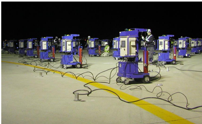
写真-1 施工状況
