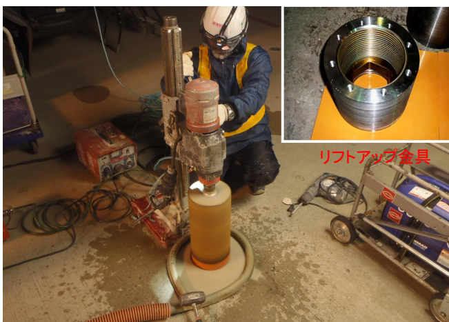
写真-2 リフトアップ金具設置状況
