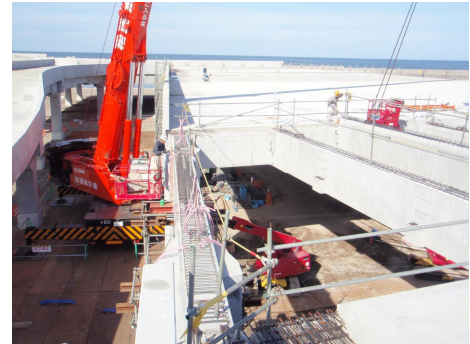
写真-4 PC梁接合部架設状況
