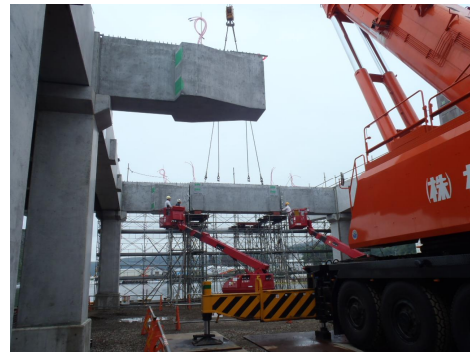
写真-3 PC梁接合部
