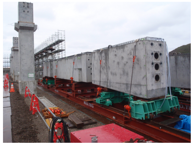
写真-5 大梁連結工 (軌条設備)
