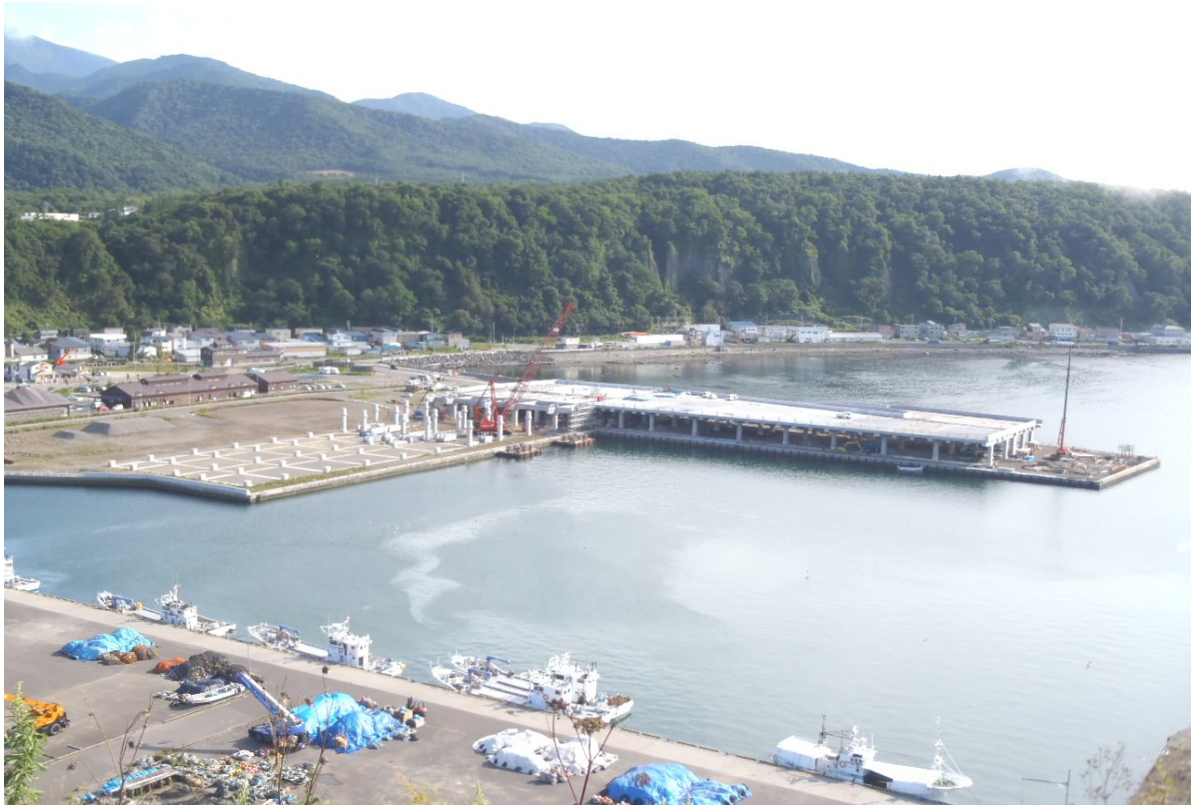
写真-9 平成24年8月28日現在の状況
