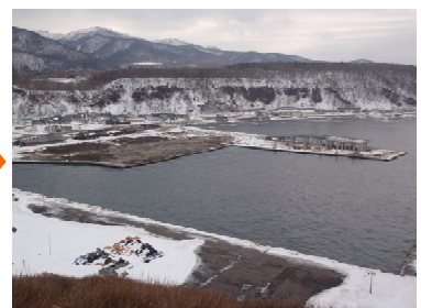
取付道路棟施工完了
