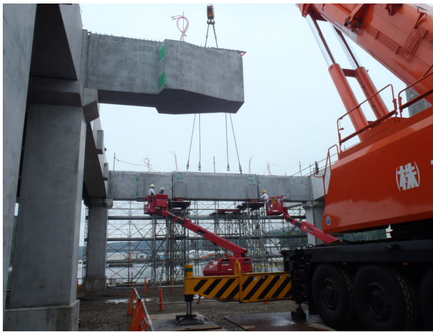
写真-6 接合部大梁架設状況
