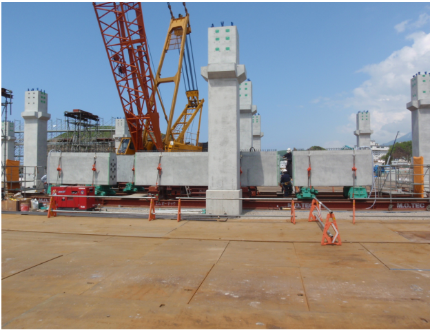
写真-4 大梁連結工 (軌条設備全景)
