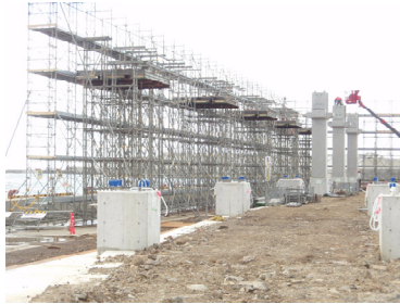
片持梁受け支保工
