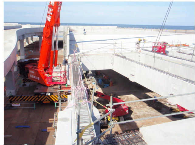
写真-7 接合部小梁架設状況
