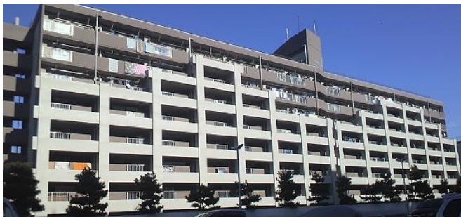
写真-1 1号棟南側補強工事後状況
