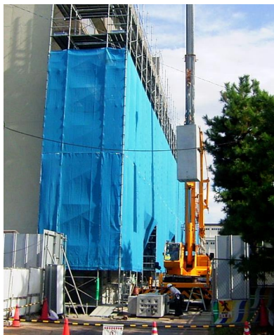
写真-2 PCa 柱部材架設状況
