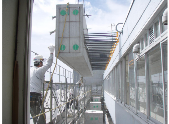
写真-2 梁架設状況
