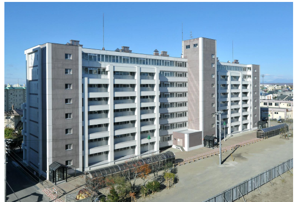
写真-3 改修後の建物外観
