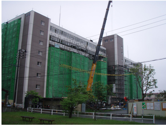
写真-1 施工時の建物外観
