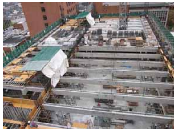
写真-3 2工区施工状況
