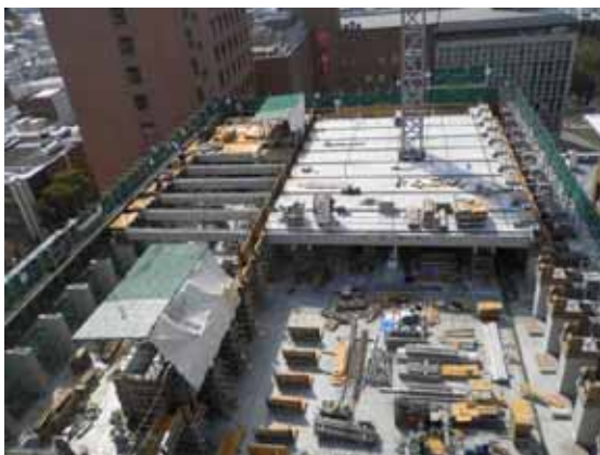
写真-2 1工区施工状況
