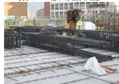
写真-6 現場打ち梁配筋
