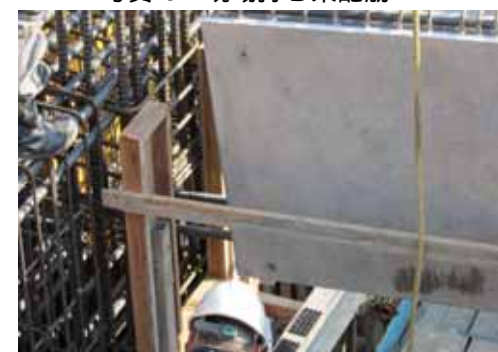
写真-7 PCa 梁架設状況
