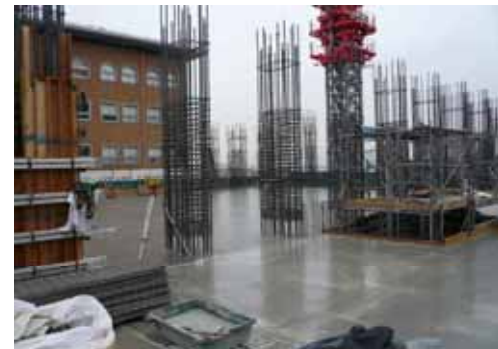
写真-5 X2 通り現場打ち柱部
