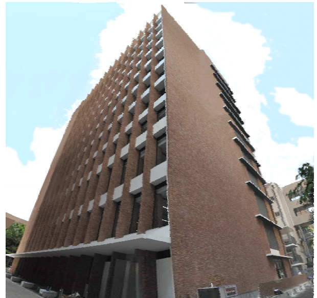
写真-1 建物外観
