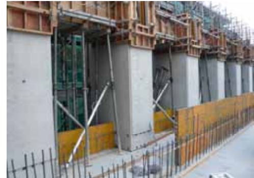
写真-4 X1 通り PCa 柱部
