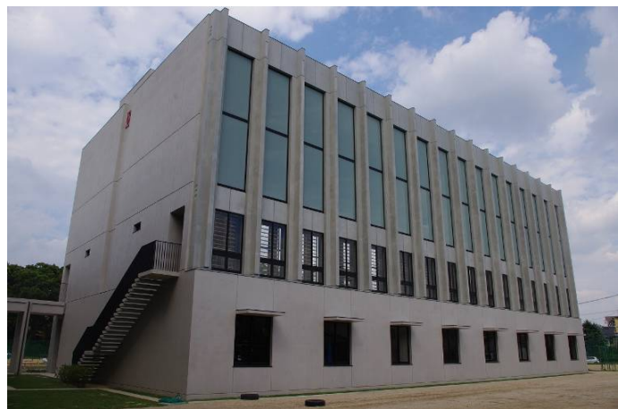
写真-1 建物外観
