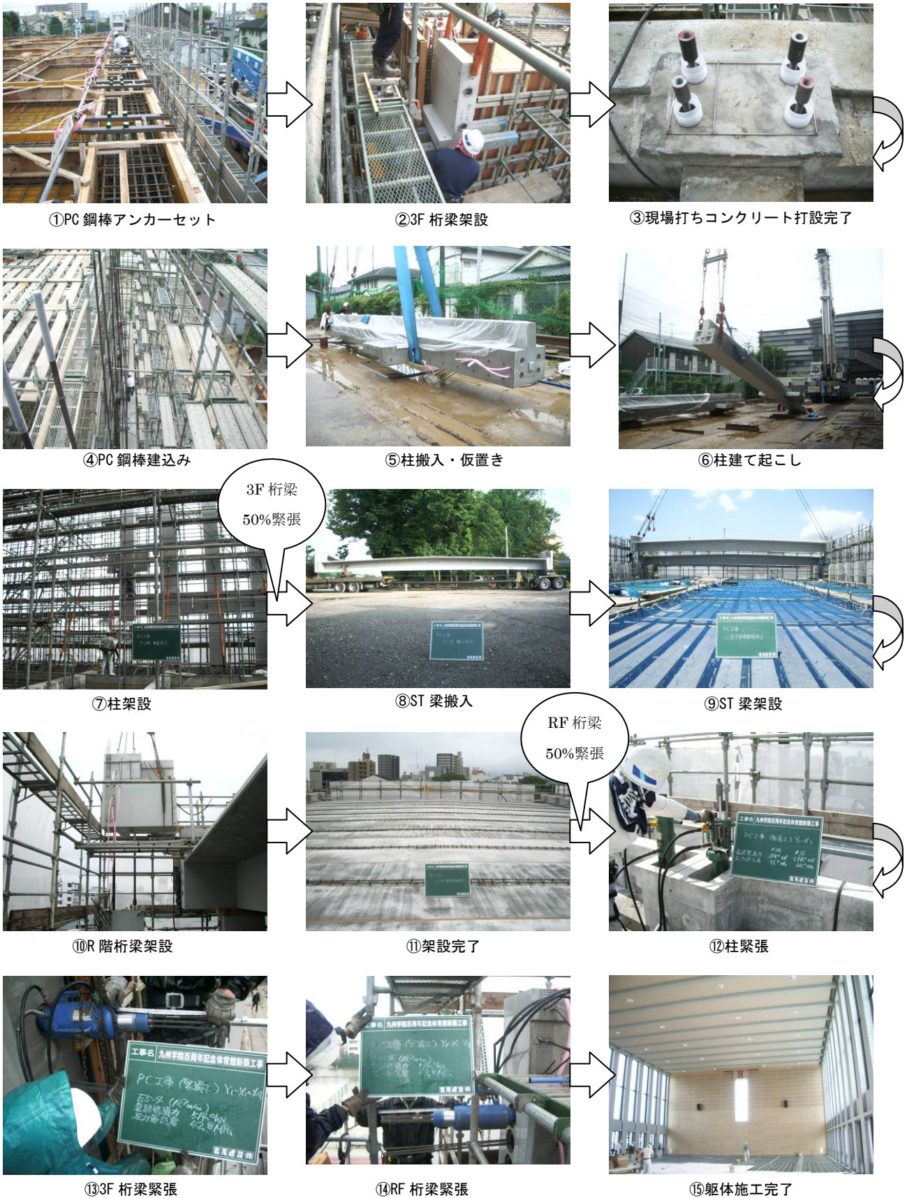
写真-10 PCa 部材施工状況
