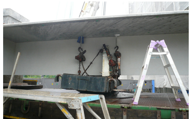
写真-8 ST 梁運搬時固定状況
