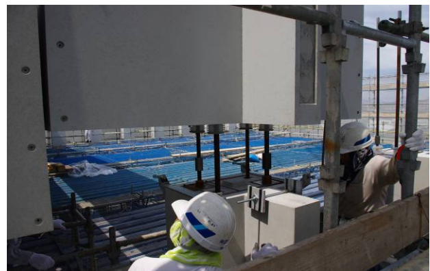
写真-12 ST 梁架設状況
