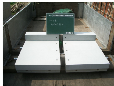
写真-4 3F桁梁
