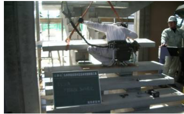
写真-13 内部階段架設状況
