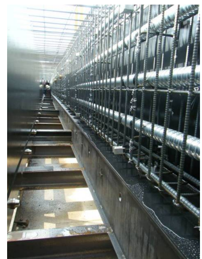
写真-9 ST 梁型枠状況
