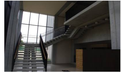
写真-14 内部階段完成後
