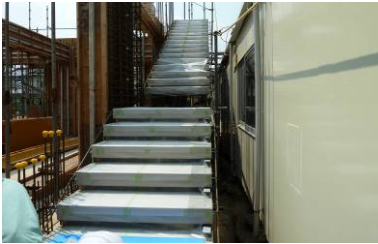
写真-15 外部階段架設状況
