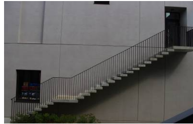
写真-16 外部階段完成後
