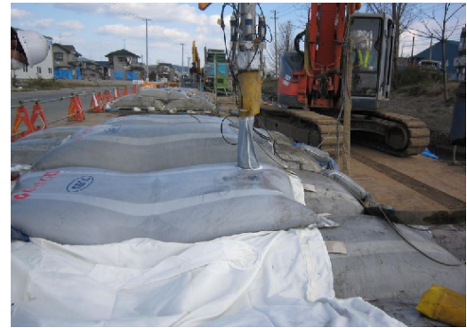
写真-2 施工状況
