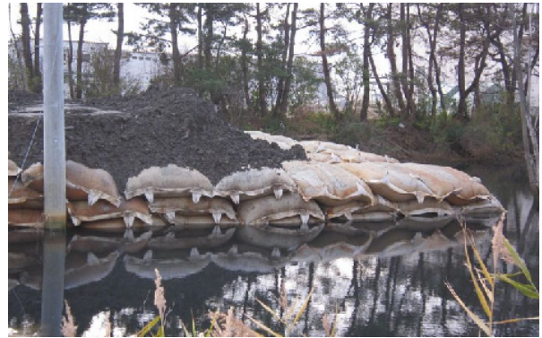
写真-4 河口付近被災箇所復旧状況
