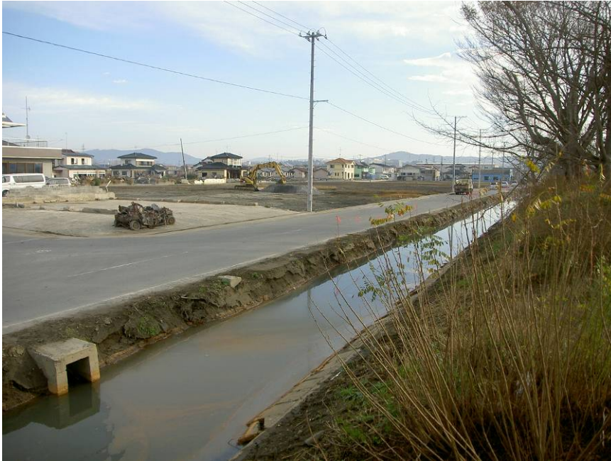
写真-5 工事完了状況
