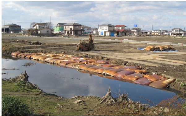
写真-3 河川崩壊箇所復旧状況
