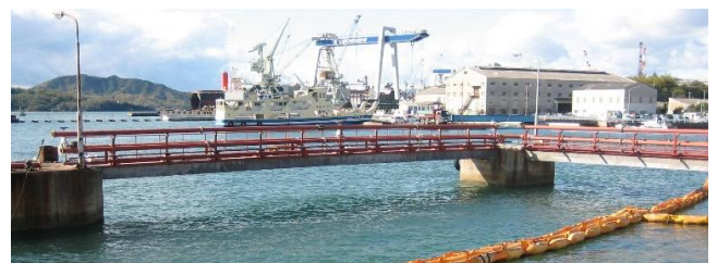
写真-3 低桁高橋(カムテックス常石栈橋)
