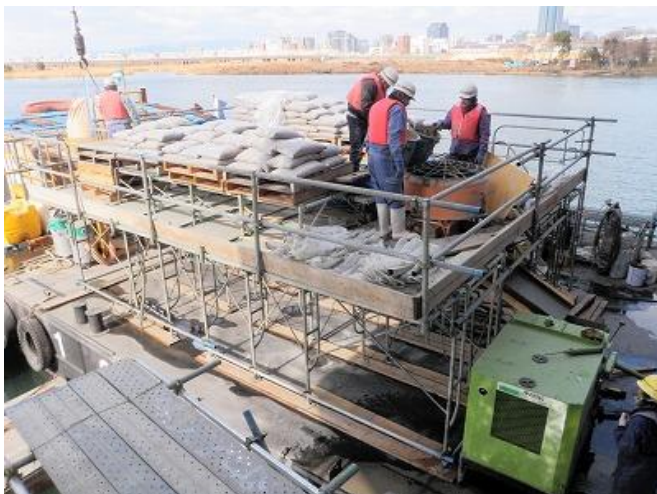
写真-2 水中不分離モルタル練混ぜ状況
