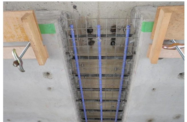
写真-4 2次コンクリート部補強状況
