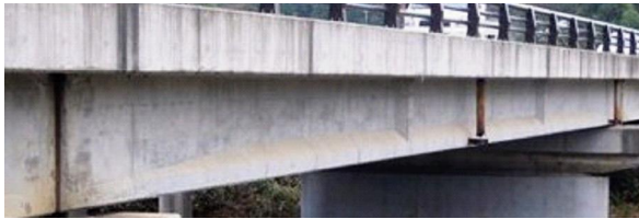
写真-1 鼻毛橋の外観
