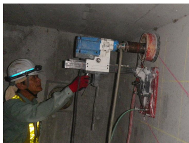
写真-4 コア削孔状況
