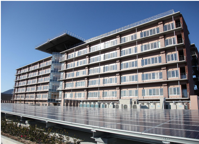
写真-1 建物全景 (南面)
