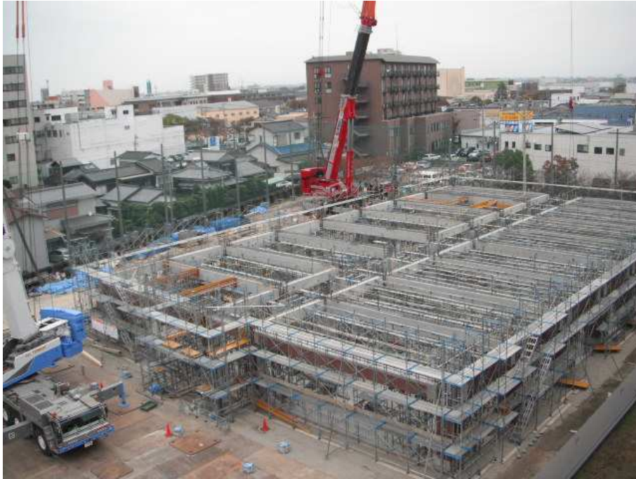
写真-3 PCa部材組み立て状況
