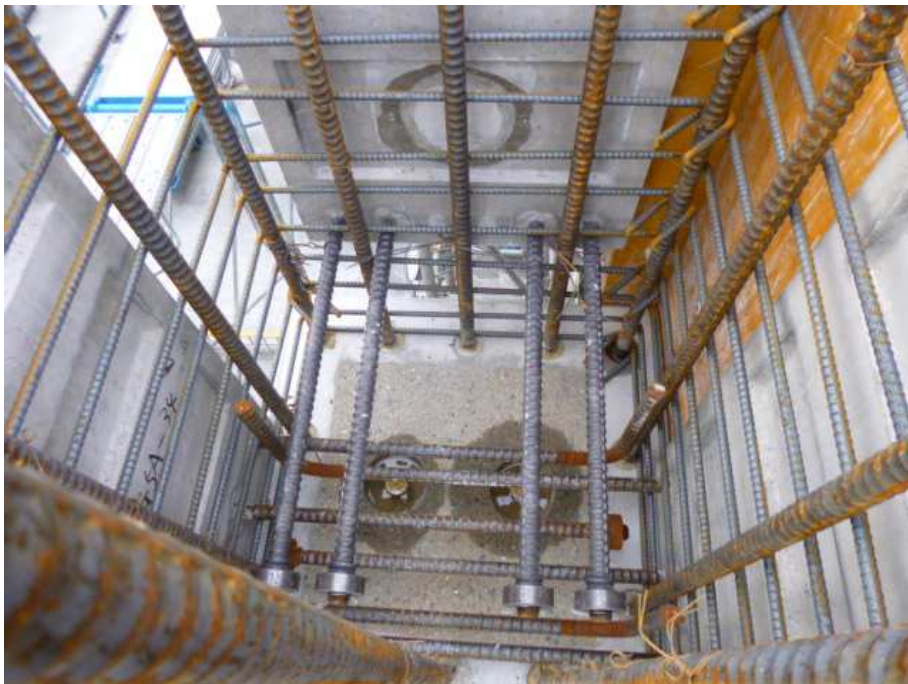
写真-2 パネルゾーン配筋状況
