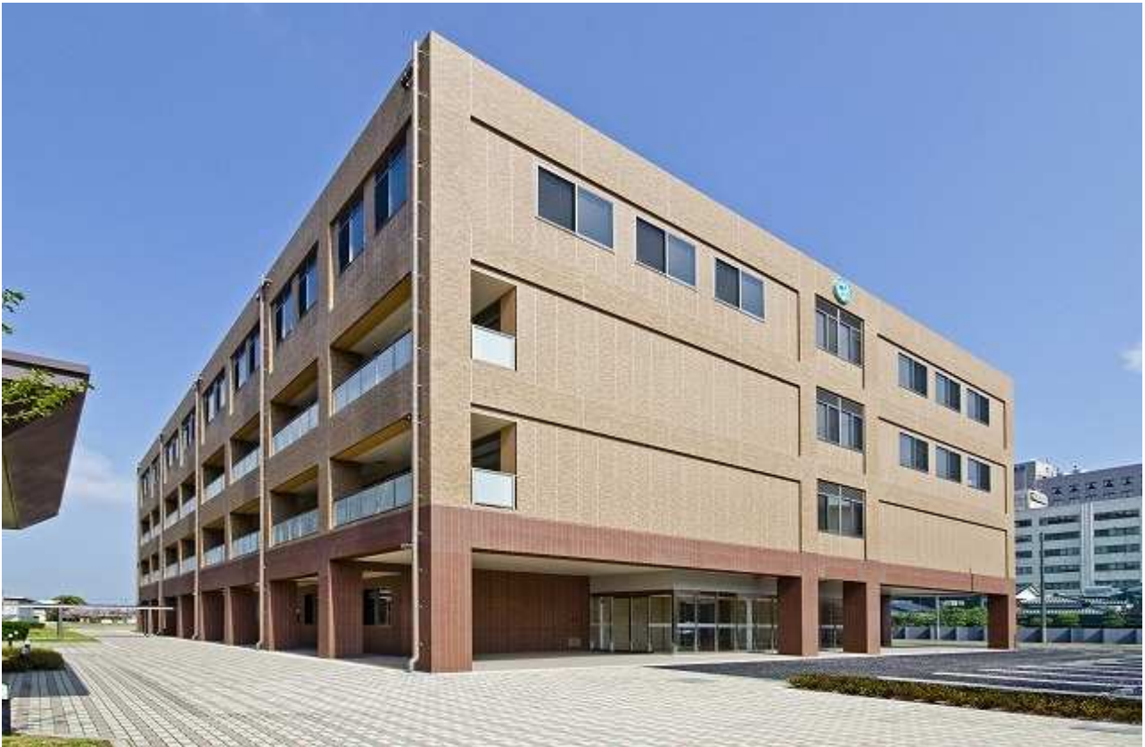
写真-1 建物外観
