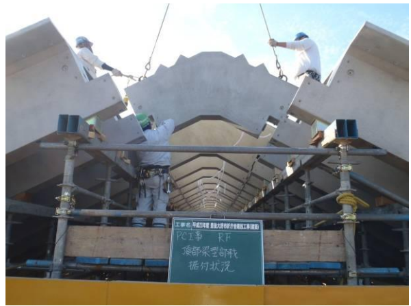
写真-6 山形 PCa 床版および頂部連結梁据付状況
