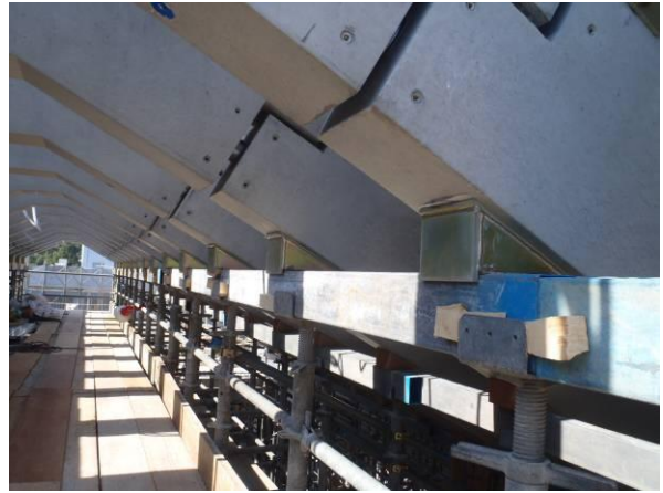
写真-5 受け金物取り付け状況
