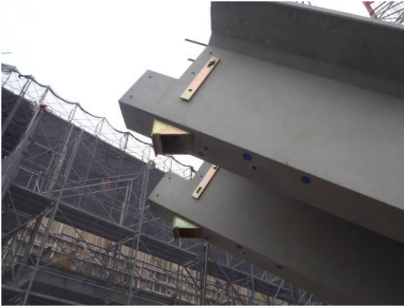
写真-5 受け金物取り付け状況
