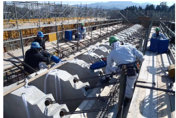
写真-7 緊張状況
