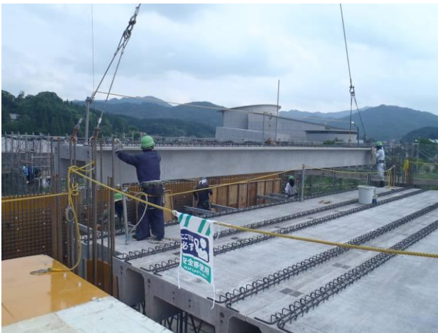
写真-3 PCa床版据付状況
