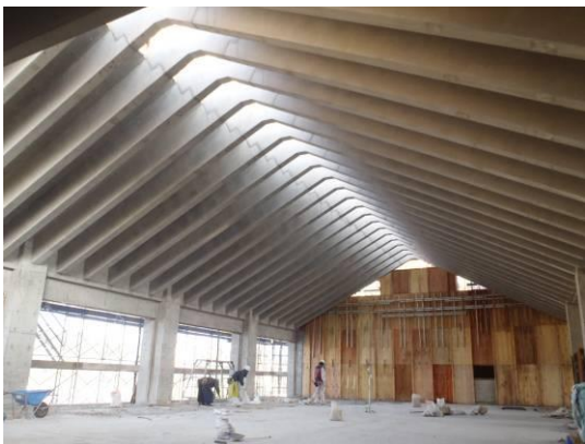
写真-8 支保工解体後
