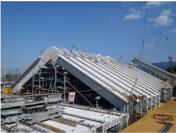
写真-6 山形 PCa 床版および頂部連結梁据付状況
