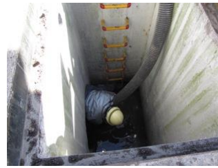
写真-2 吸引状況
