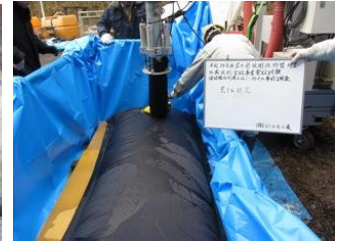
写真-3 充填状況
