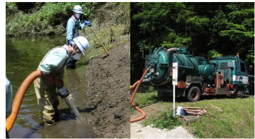
写真-1 集泥・吸引状況とバキューム車
