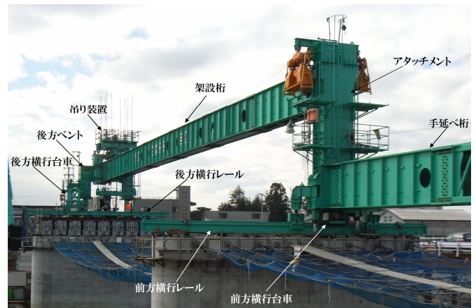
写真-1 設置状況
