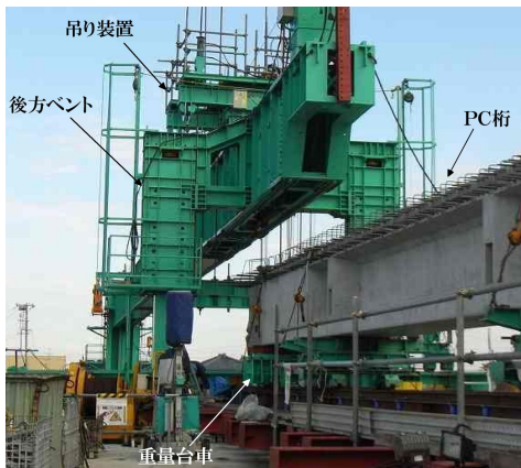
写真-2 PC桁縦移動状況
