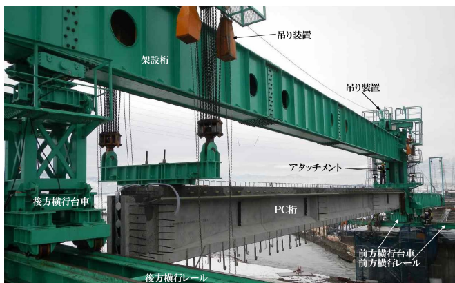
写真-3 PC桁架設状況
