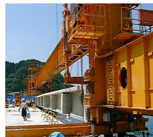
写真-5 撤去工事
