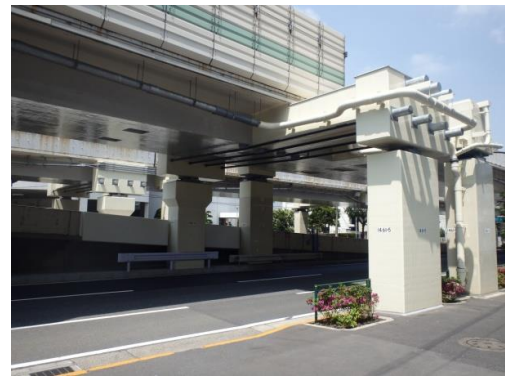
写真-2 新設下部工・横梁完成状況
