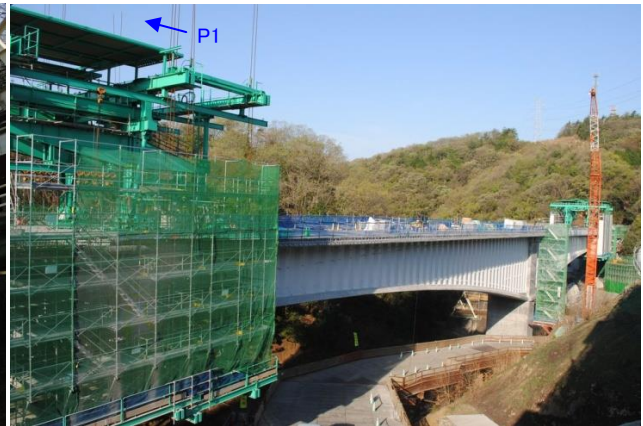
写真-4 橋体施工状況
