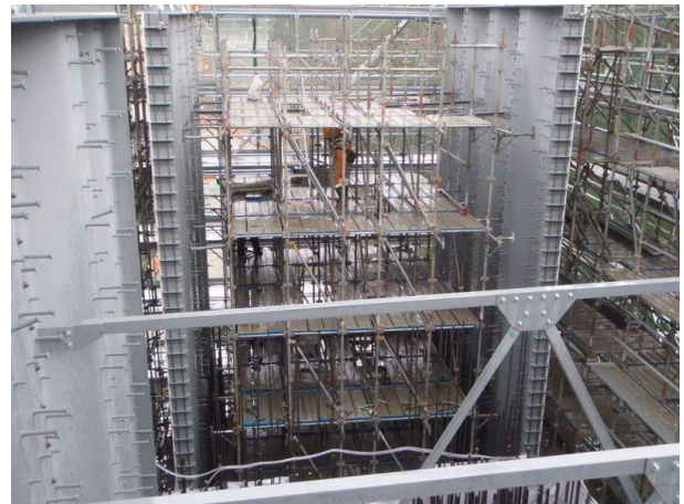
写真-1 柱頭部施工状況
