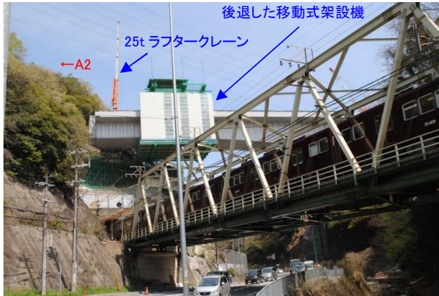
写真-3 クレーンと移動架設機の置換状況
