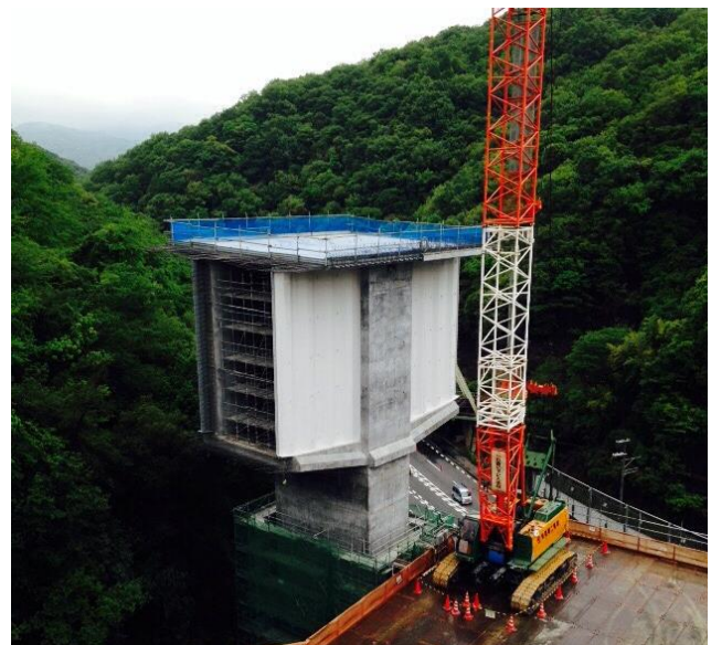
写真-2 柱頭部施工完了
