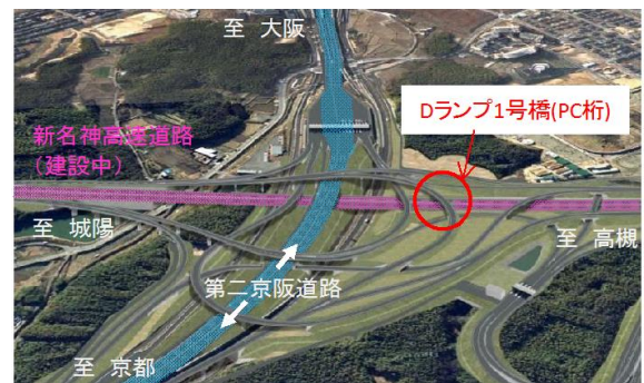
図-1 八幡 JCT・D ランプ 1号橋の PC 桁架橋位置
