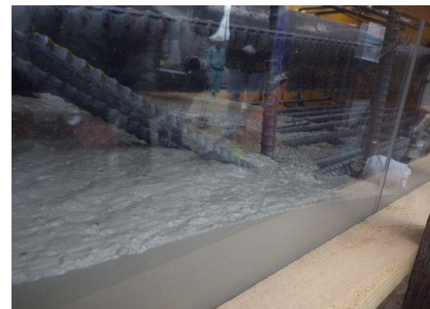
写真-2 充填状況(型枠側面)
