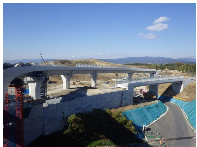
写真-7 完成状況
