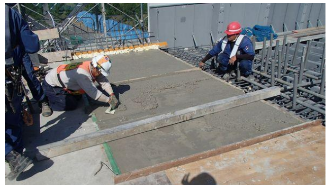
写真-6 伏せ枠解体後の天端仕上げ状況
