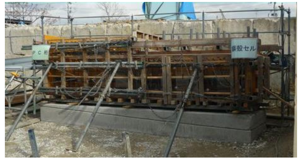
写真-1 打設実験用型枠
