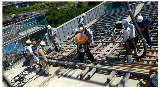
写真-5 接合部のコンクリート打設状況
