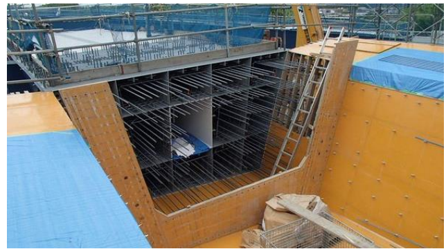
写真-4 鋼殻セルおよび接合部の型枠組立状況
